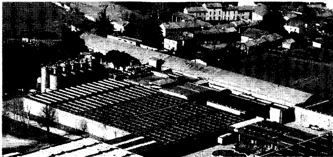
I pannelli fotovoltaici sui tetti della Piberplast
